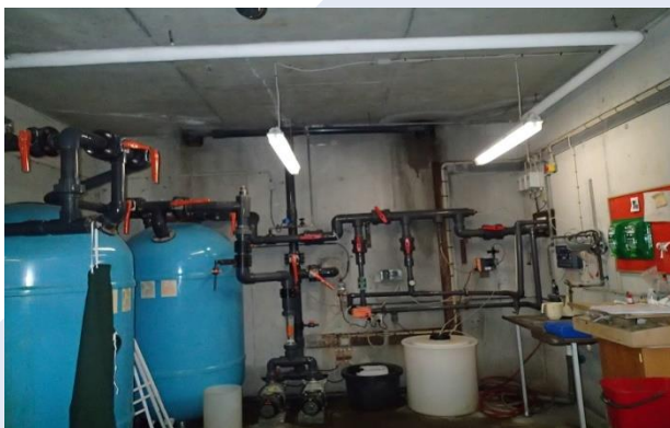
Vandindrængen i teknikrum
