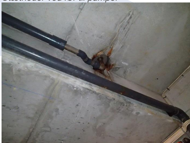
Afløb fra skimmekasser er utætte
