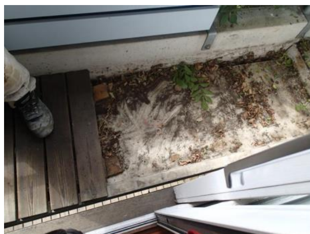
Under nogle af altanbrædderne er der fugtigt muld.
